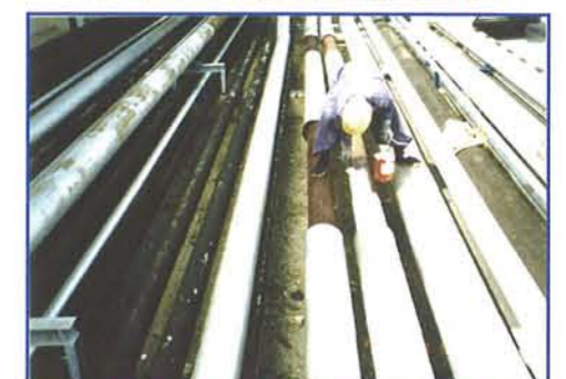
従来保温材よりも少ないスペース 狭いスペースでも保温効果と結露対策ができます
