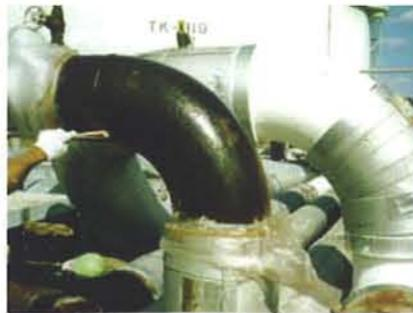
無黄変・無溶剤・一液性のバインダーです。高粘度のため、高所作業での強風による塗料の飛散を抑えることができ、刷毛、ローラーで簡単に塗布できます。
