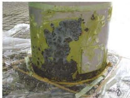
STR-10施工中 浮きサビ、こぶサビ、劣化皮膜(3種ケレンレベル)の除去でサビの上から直接塗布できるため、下地処理の労力と経費を大幅に軽減できます。
